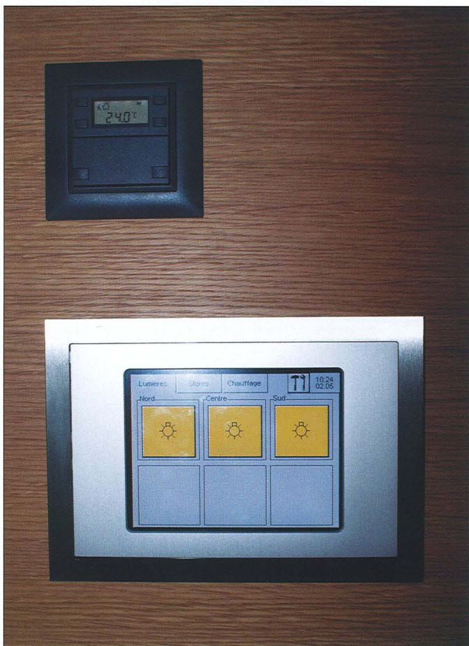
Chaque bureau est équipé d'un écran tactile et d'un thermostat.
