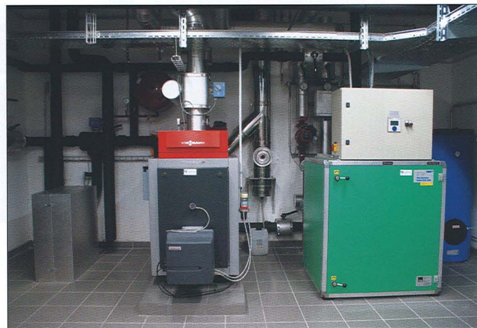
Vue générale de la chaufferie: à gauche l'échangeur de chaleur, au centre la chaudière à mazout d'appoint, à droite la pompe à chaleur d'une puissance frigorifique de 42,5 kWh.
