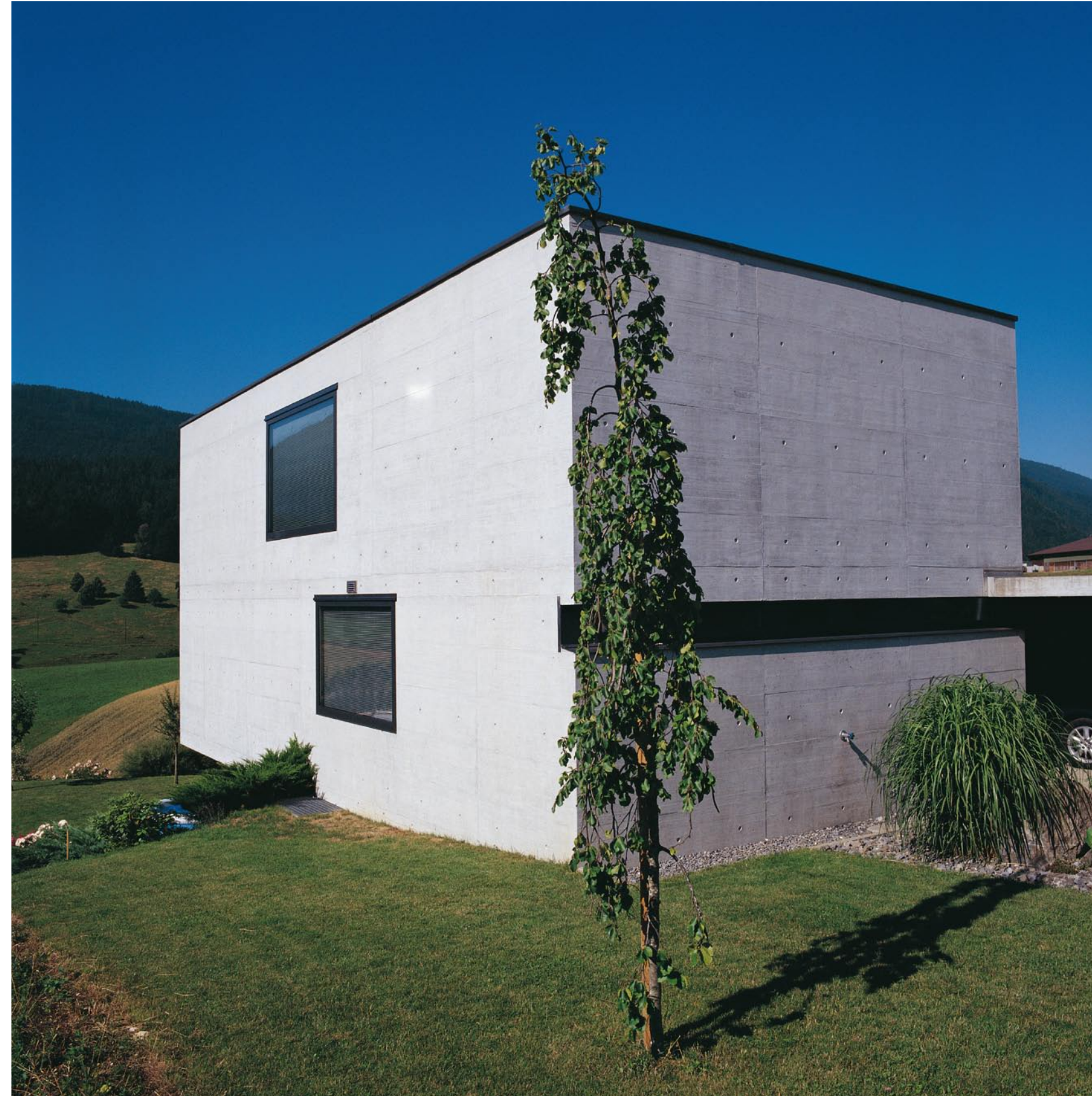
Grande image La construction est née d'une réflexion sur le lieu, sa situation géographique et le climat. 1+2 Le choix subtil des matériaux a permis de créer une maison lumineuse et élégante. 3 La parcelle accuse une forte pente qu'il a fallu apprivoiser.
